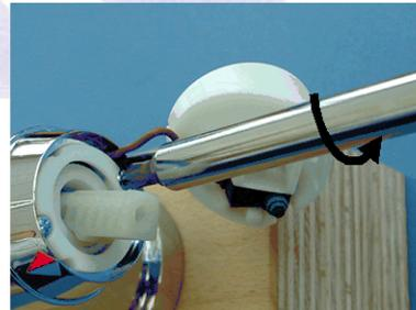
**5. Lösen Sie die drei Schrauben der Kartuschenhalterung (TorxT8®)**
