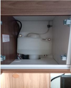
3.) Deckel der Alde Heizung öffnen und 4 Kabel abstecken
