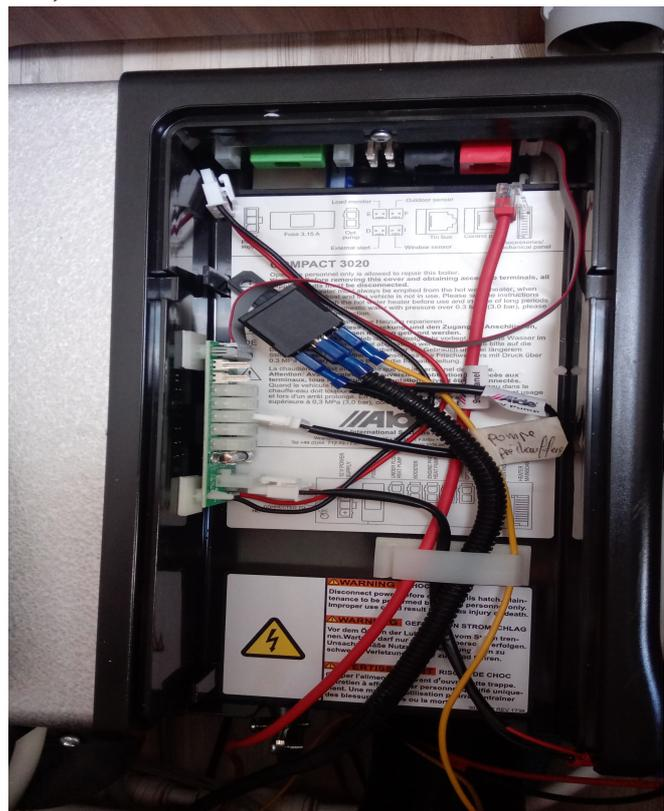
4.) ca. 5-10 Min. warten, Kabel wieder einstecken und danach das Display der Alde Heizung wieder einschalten. Reset am Display durchführen und Einstellungen wieder herstellen.
